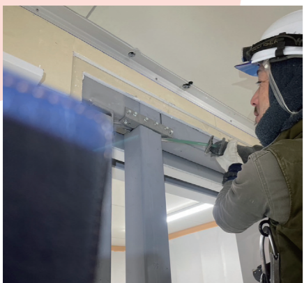
▲既存鉄骨下地の改造中
